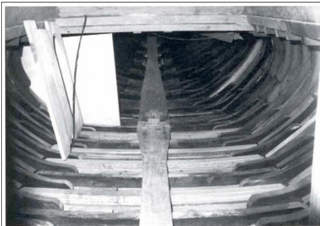
(fig. 7) Spantconstructie van de Windroos
