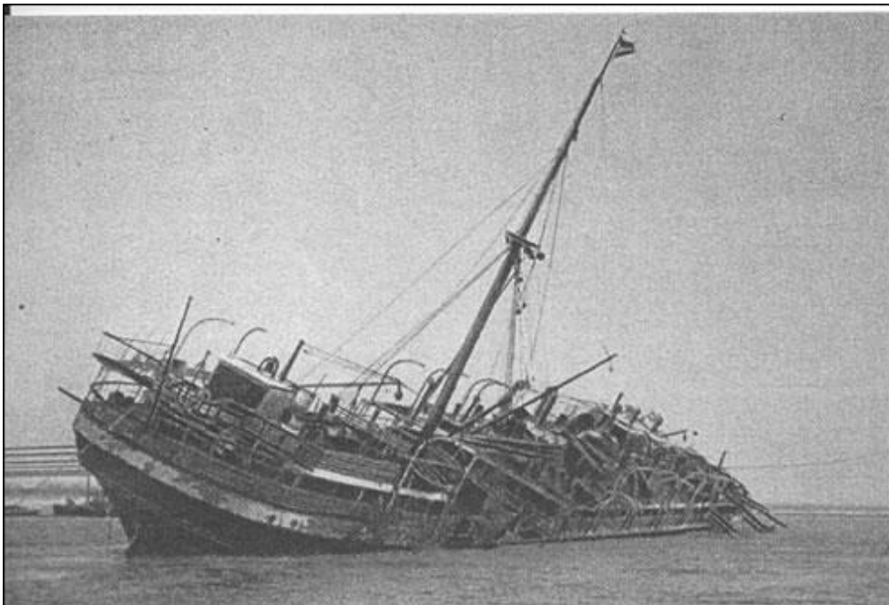
Foto 7: Zicht op de achtersteven. Nog 25 graden te gaan en de Gneisenau ligt terug rechtop. De voormast is afgebroken en de schouw is weg.
