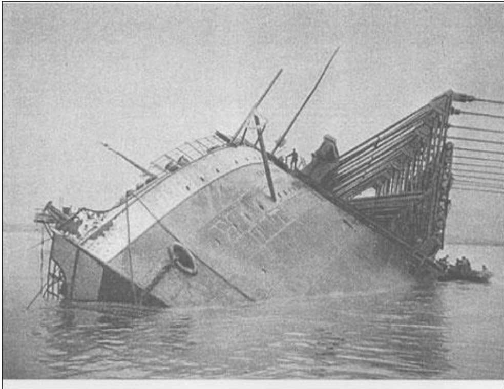
Foto 5: Deze historische foto geeft een detail weer van de constructie van de driehoekige kantelarmen die de treklijnen meer
